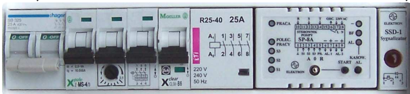
Rys. 2. Zespół sterowania pompy ( przykład)
