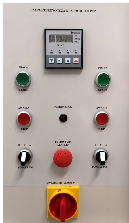
Rys.1 Sterownik SP-41P + zespół przełączników/przycisków do sterowania pomp.
